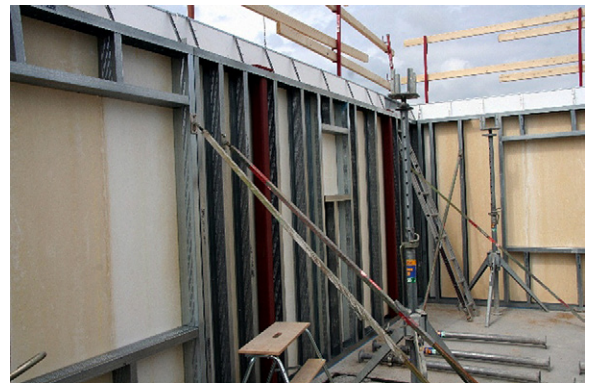
Väggelementen hålls på plats med justerbara väggstag.
